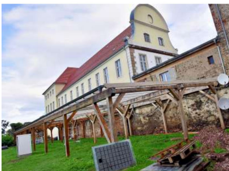
Das Holzgestell des künftigen Wintergartens ist bereits aufgestellt.
