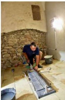
Denis Herrmann von der Quedlinburger Bauhütte beim Fliesenlegen für die Sanitäräume im Schloss.
